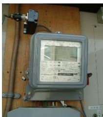
電力会社により接続された信号を本体へ
